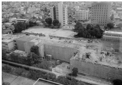
建替えのため解体工事が進む桃井小学校
