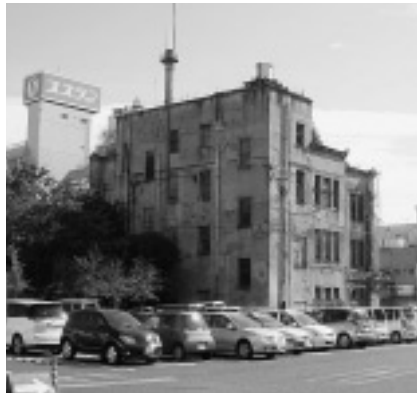
解体が行なわれている旧麻屋百貨店
