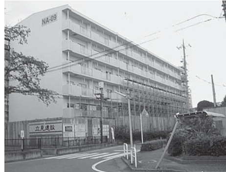
建設工事が進む南橋団地の市営住宅
