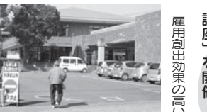
大規模改修工事が行われるしきしま老人福祉センター
